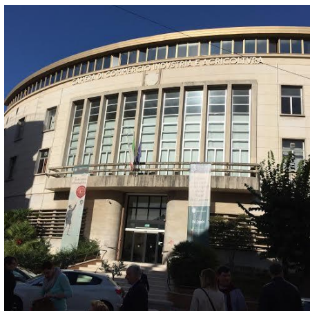
A cosenzai Kereskedelmi, Ipari és Mezőgazdasági Kamara épülete
